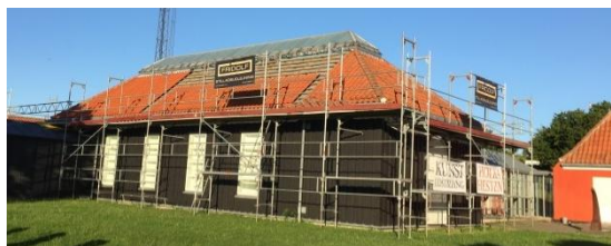
Stillads står klar til etablering af nyt undertag
